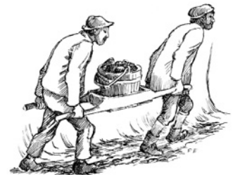
Transport mit der Handtrage
