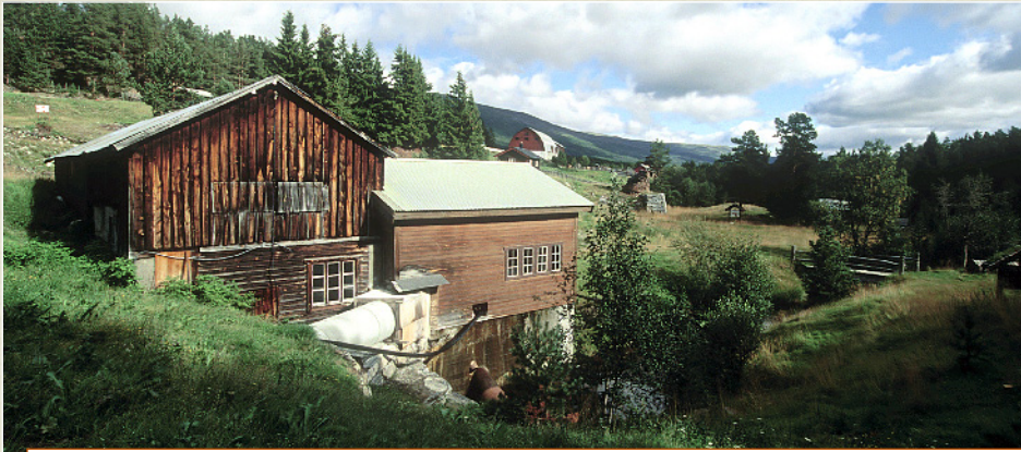
Blick auf den Kultursti Lesja jernverk. Im Vordergrund das heutige Wasserkraftwerk.
