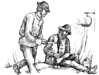
Sprenglöcher wurden mit einem Handbohrer gebohrt
