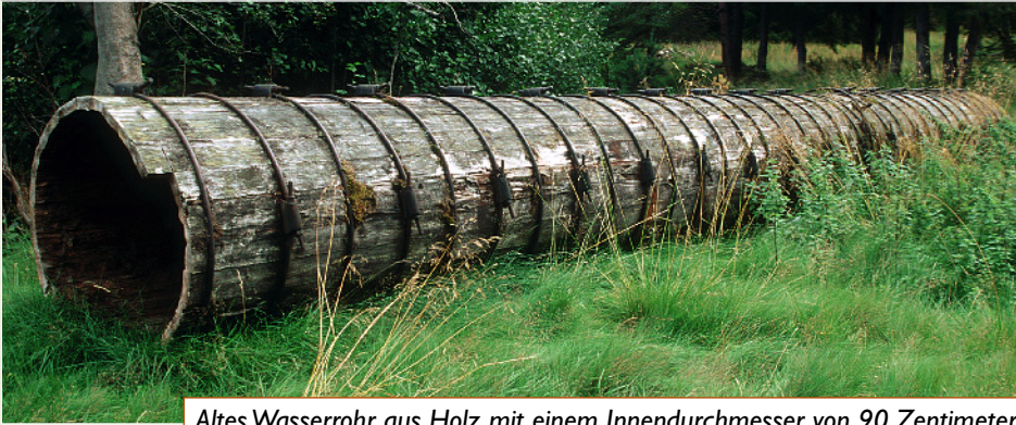
Altes Wasserrohr aus Holz mit einem Innendurchmesser von 90 Zentimetern
